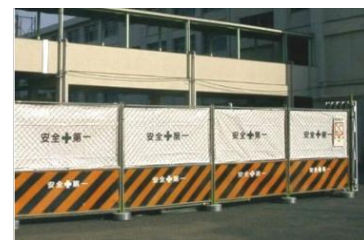
交換後仮囲い
